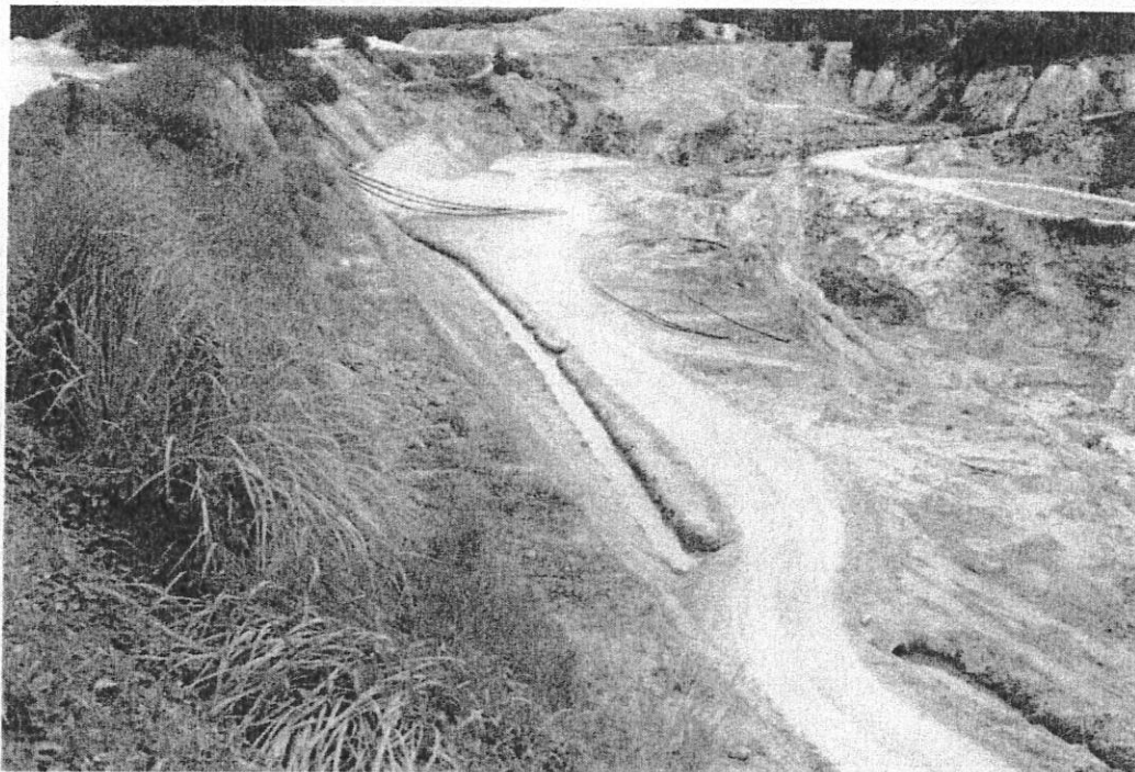
ภาพที่ 5 คูระบายน้ำบนคันดิน เพื่อป้องกันปัญหาน้ำเซาะแล้วเกิดดินไหล
